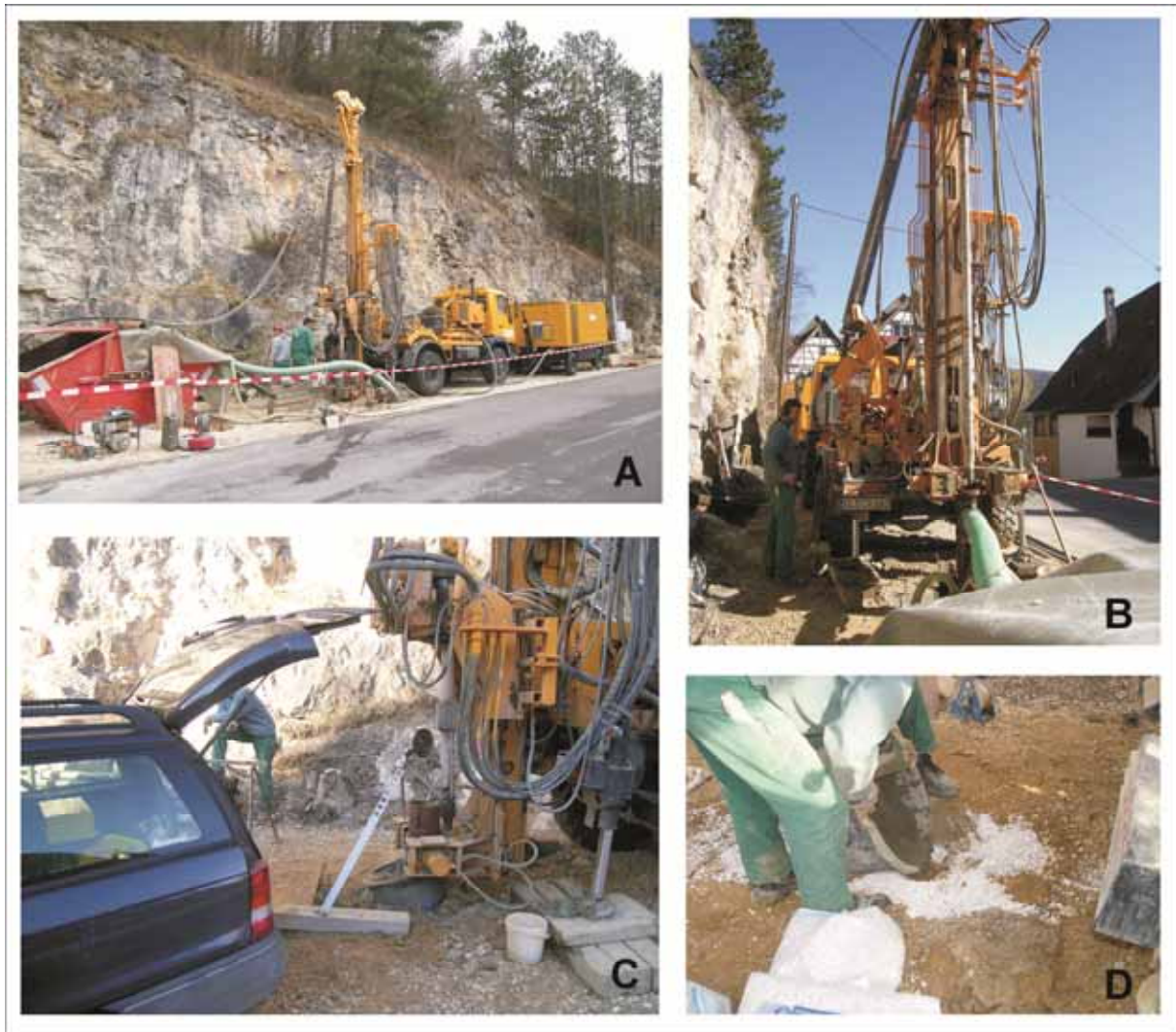
Abb 2: Die Bohrung Schimmelmühle.
